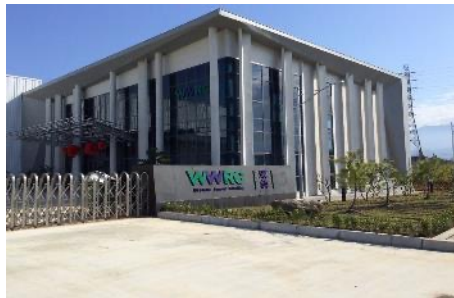
嘉義大埔美工業區 R&D center and warehouse
